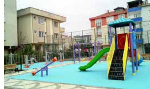
» Bıçkın Sokak park yapımı
