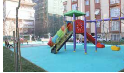
» Aslanağzı Sokak park yapımı
