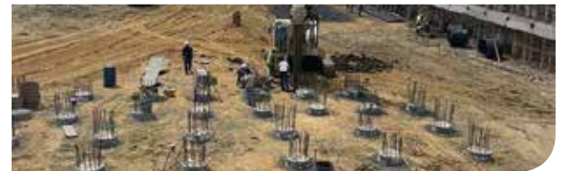
Temel Altı Kazık ve Fore Kazık Çalışması
