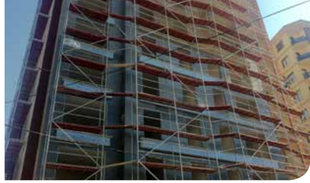
Dış Cephe Yalıtımı
